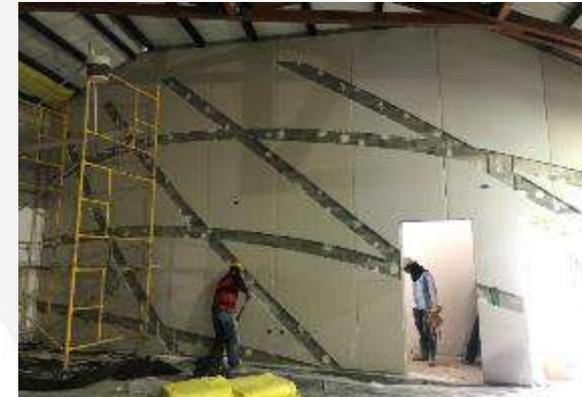
Al interior, el revoque seco en las paredes laterales del auditorio para conformación de detalle de acabado en forma de flor.
