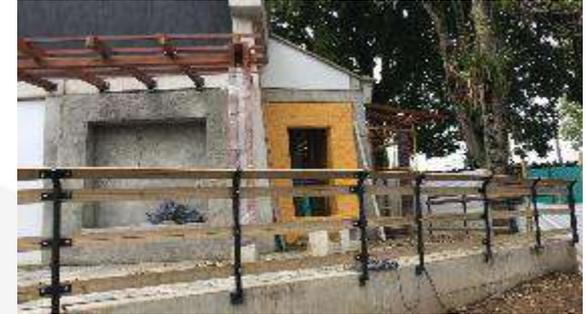
Se encuentra en proceso la construcción de las obras de urbanismo, los senderos en adoquín peatonal, la pintura de muros, instalación de pasamanos en madera rolliza de pino.
