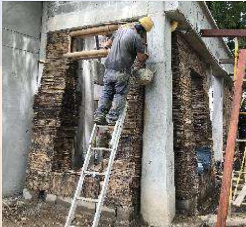
Proceso constructivo de muros en bahareque, con revoque y acabado en pintura Koraza.
