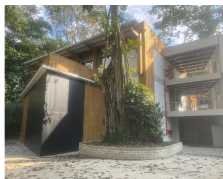
Edificio 18C Centro de Transformación de la Madera
